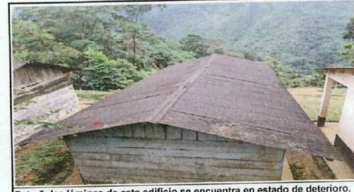
Foto 6: las láminas de este edificio se encuentra en estado de deterioro.
